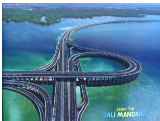
バリ・マンダラ高速道路
